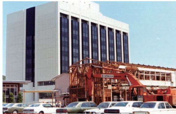
昭和51年 (1976年) 7月 君津市役所新庁舎が完成 手前に見えるのは解体途中の旧庁舎
