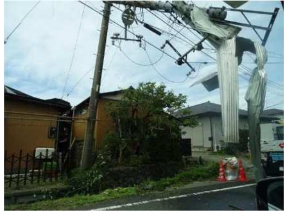
台風第 15 号による電柱等被害の様子
