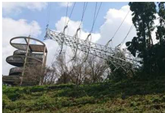
台風第 15 号によるアカデミアパーク周辺の鉄塔被害の様子
