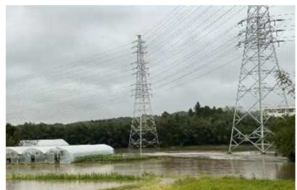
10月25日大雨による中村橋周辺の様子
