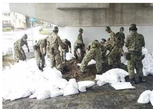
自衛隊による土のう作成の様子
