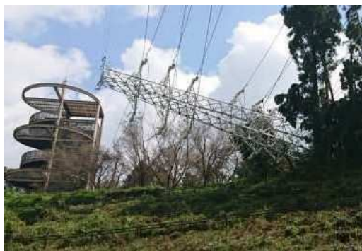
アカデミアパーク周辺の鉄塔被害の様子
