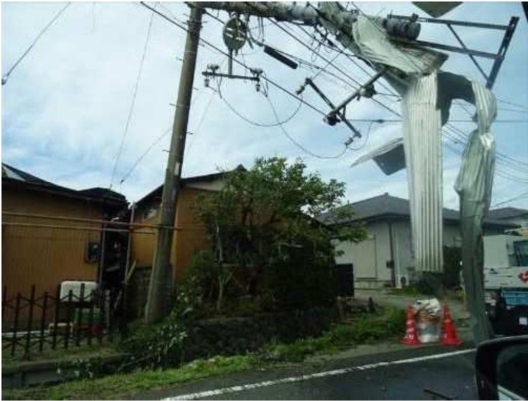
電柱等被害の様子
