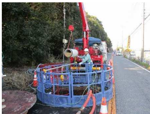
下水道工事の様子
