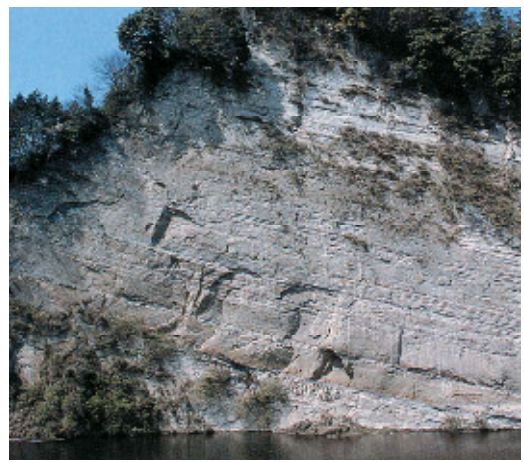
おりきさわはしふきん 折木沢橋付近
