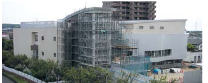
建設中の（仮称）生涯学習交流センター
