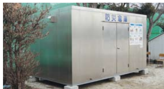
指定避難場所などにコンテナ式防災倉庫を設置
