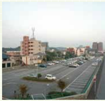
利用促進が望まれる市営坂田駐車場
