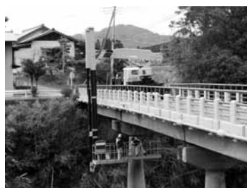
老朽化した橋梁を計画的に修繕
