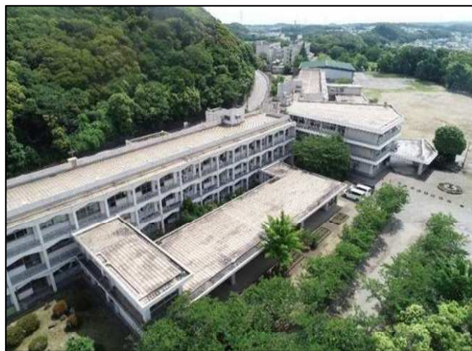
（柱 5 - 4 公共施設マネジメント）
