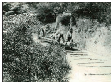
▲昭和8（1933）年、木馬（上を滑らせて運ぶ木ぞり）を使って電柱に使う材木を運び出す様子
