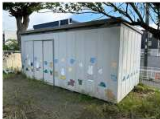
附属建物4(倉庫)
