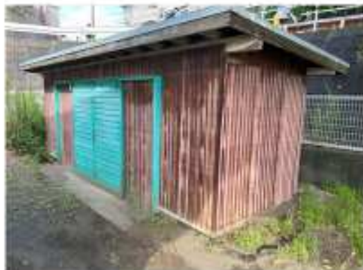
附属建物2(倉庫)
