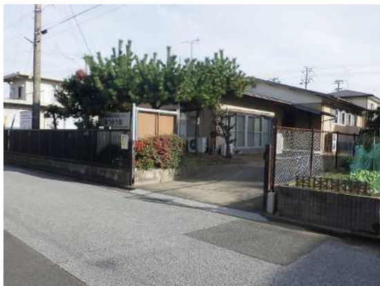
② 建物用地内
