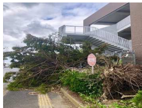
台風15号による倒木被害
