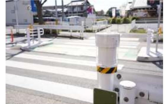
◆ 日が落ちる時間帯に作動し、横断者が近づくと、下記3種類の光で横断を支援する。
