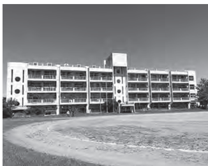
長寿命化改修工事を行う管理普通教室棟
