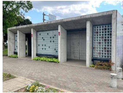
【 西側駐車場トイレ 】
