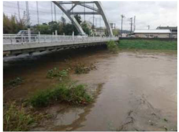
君津新橋付近増水の様子
