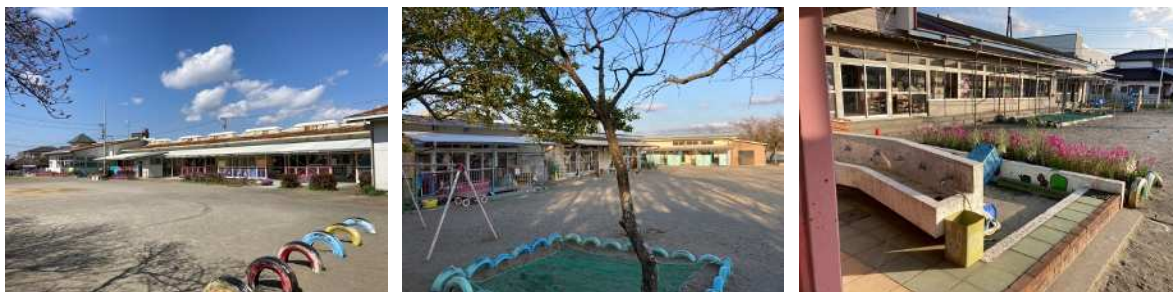
瞬時倒壊を防ぐ安全対策工事を実施した木造園舎(久保保育園、上湯江保育園、常代保育園)
