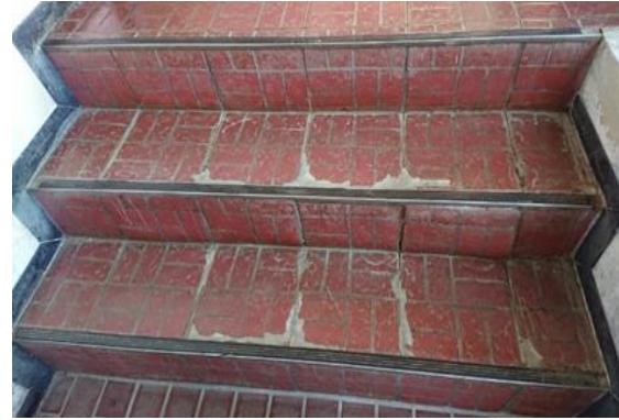
階段・内部仕上
