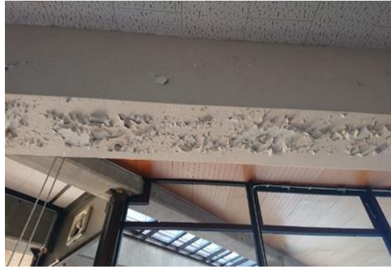
天井・内部仕上
