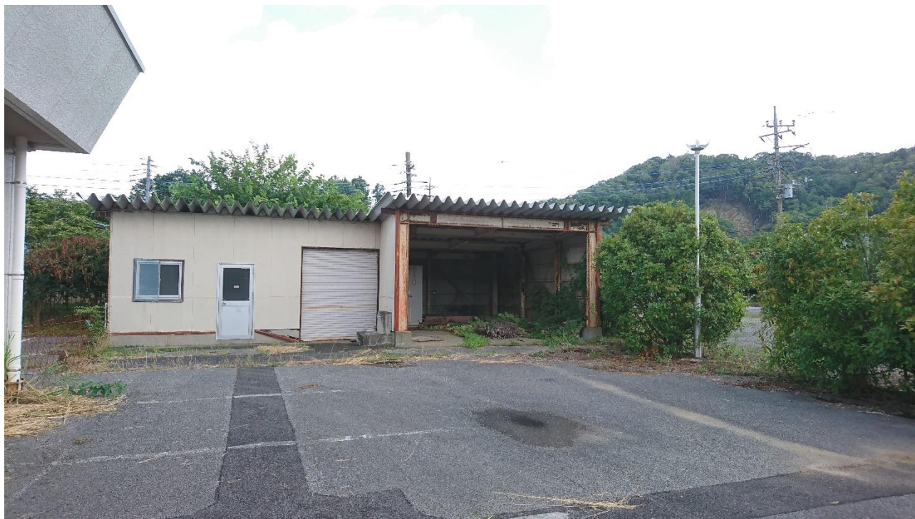
旧きみつ自然体験センター清和ふれあい館 倉庫①
