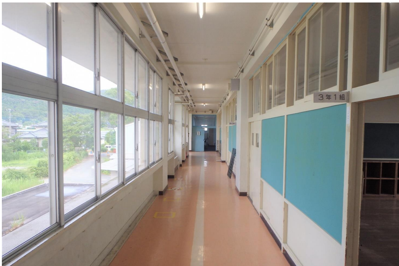
旧小糸小学校 廊下
