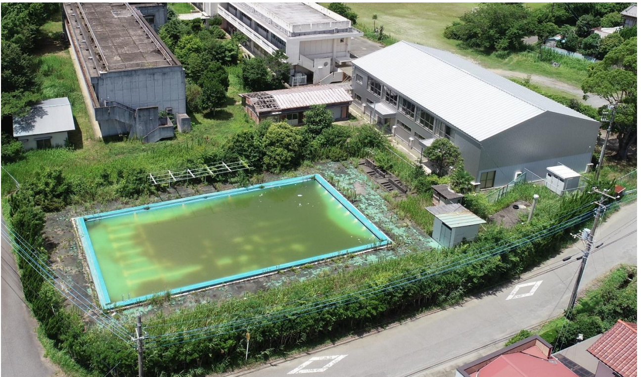
旧小系小学校 プール
