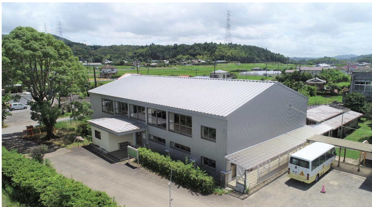
旧小系小学校 屋内運動場外観
