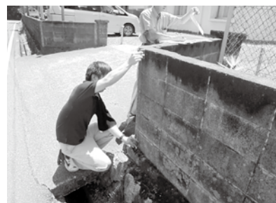
ブロック塀現地確認の様子
