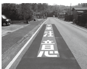
カラー舗装、路面標示
