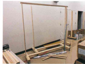
作成途中の飛沫防止パネル
