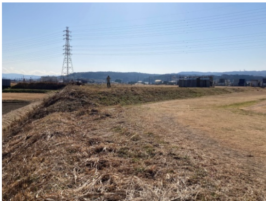
C 貞元グラウンドから計画地方向を見る 段状に計画地側が高くなっている 左側にある田畑との高低差は3m弱
