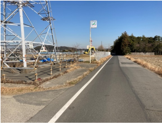
A（前頁地図に撮影点を記す。以下同様） 東側前面道路（貞元・喜平線） 道路幅員は約4mで歩道未整備 左側奥が計画地で道路とほぼ平坦に接続する 左側手前には計画地外にある送電用鉄塔が見える
