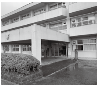
貞元小学校 特別教室棟
