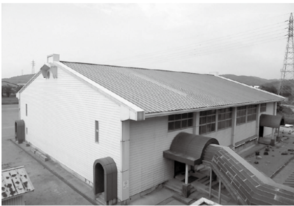
上総小櫃中学校体育館
