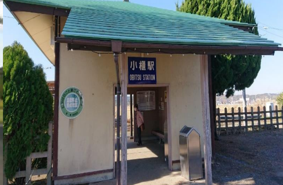
小櫃駅舎（屋根、外壁）
