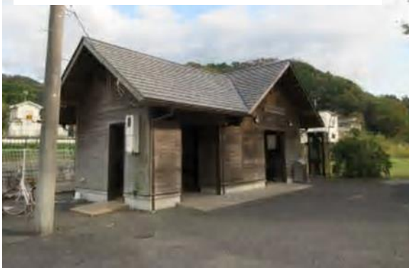
松丘ふれあい館（屋根・屋上）
