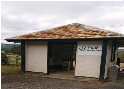
平山待合室（屋根、外壁）
