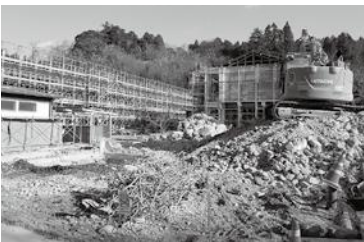
（仮称）上総地区小学校工事の様子
