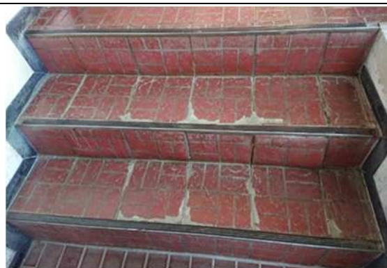
階段・内部仕上
