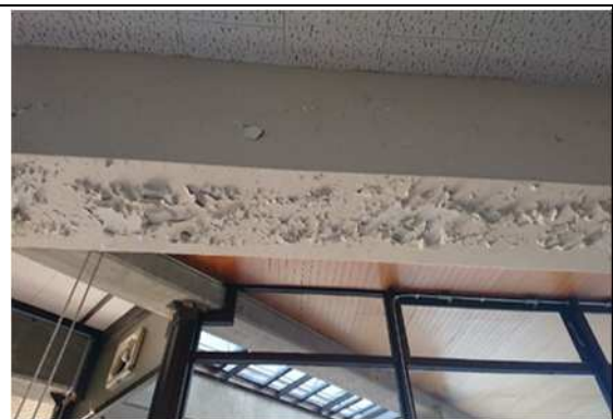
天井・内部仕上
