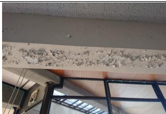
天井・内部仕上
