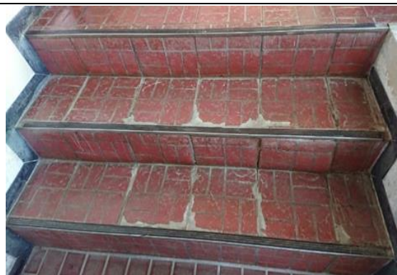
階段・内部仕上
