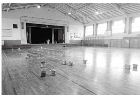
周西南中学校屋内運動場
