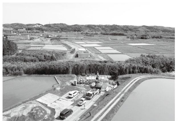
八重原線道路新設の様子
