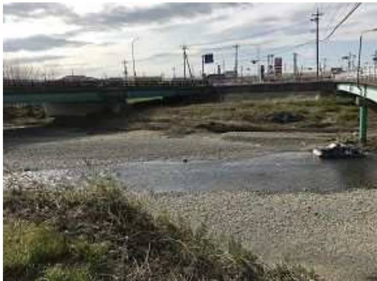
※秋山川決壊現場付近
