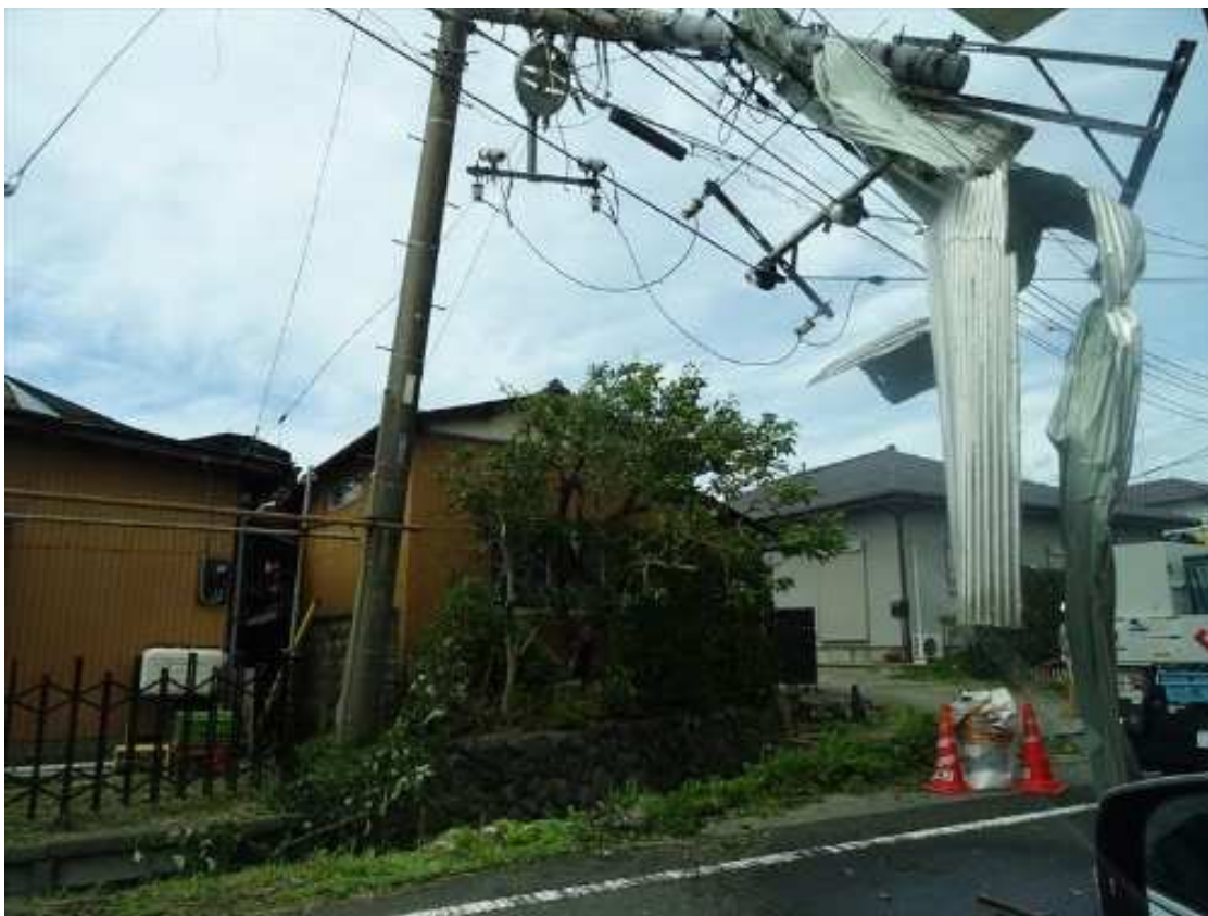
電柱等被害の様子
