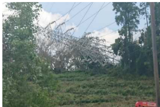
アカデミアパーク周辺の鉄塔被害の様子
