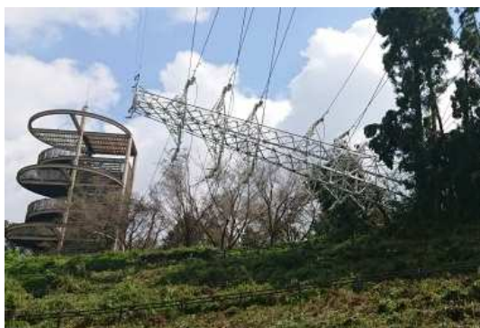
アカデミアパーク周辺の鉄塔被害の様子
