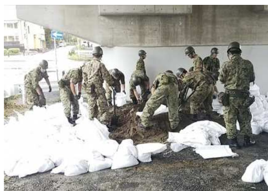
自衛隊による土のう作成の様子
