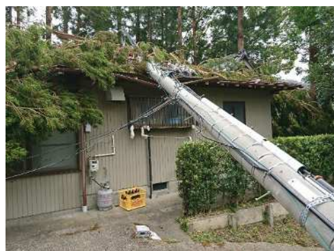
建物被害の様子
