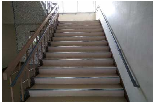
階段両手摺り設置
