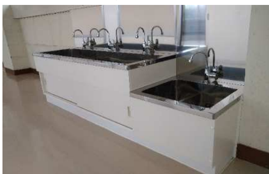
流し台の高さ改修
