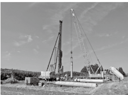
八重原線道路新設の様子
