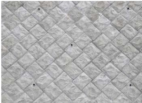
コンクリートブロックに凹凸のある表面仕上げを施している
