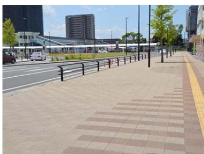
高質化した道路舗装（君津駅北口）
