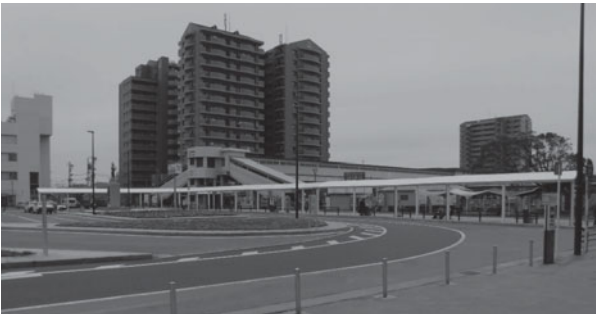
完成した君津駅北口バスシェルター
