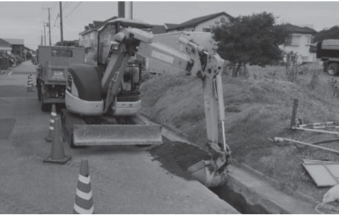
有収率向上のための老朽管更新工事
