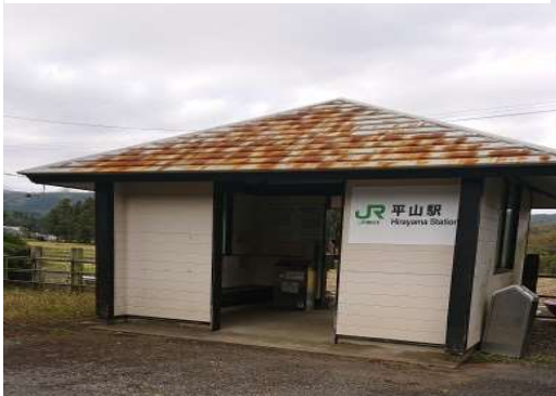
平山待合室（屋根、外壁）
