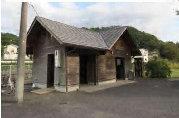
松丘ふれあい館（屋根・屋上）
