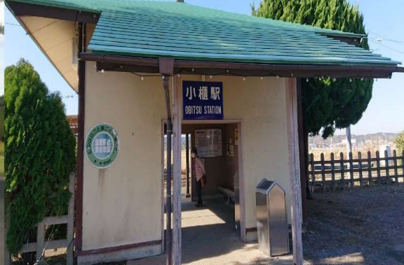
小櫃駅舎（屋根、外壁）
