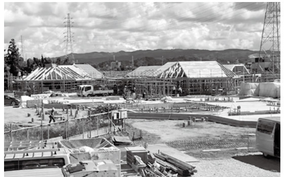
建設工事が進められている みふねの里保育園
