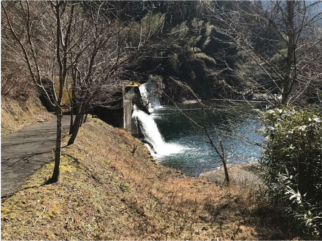
○栲原町 小水力発電所
