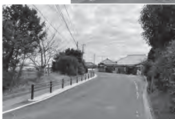
貞元地先のガードパイプ
