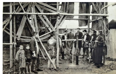
【上総掘りで掘削した人吉温泉(昭和初期)】
